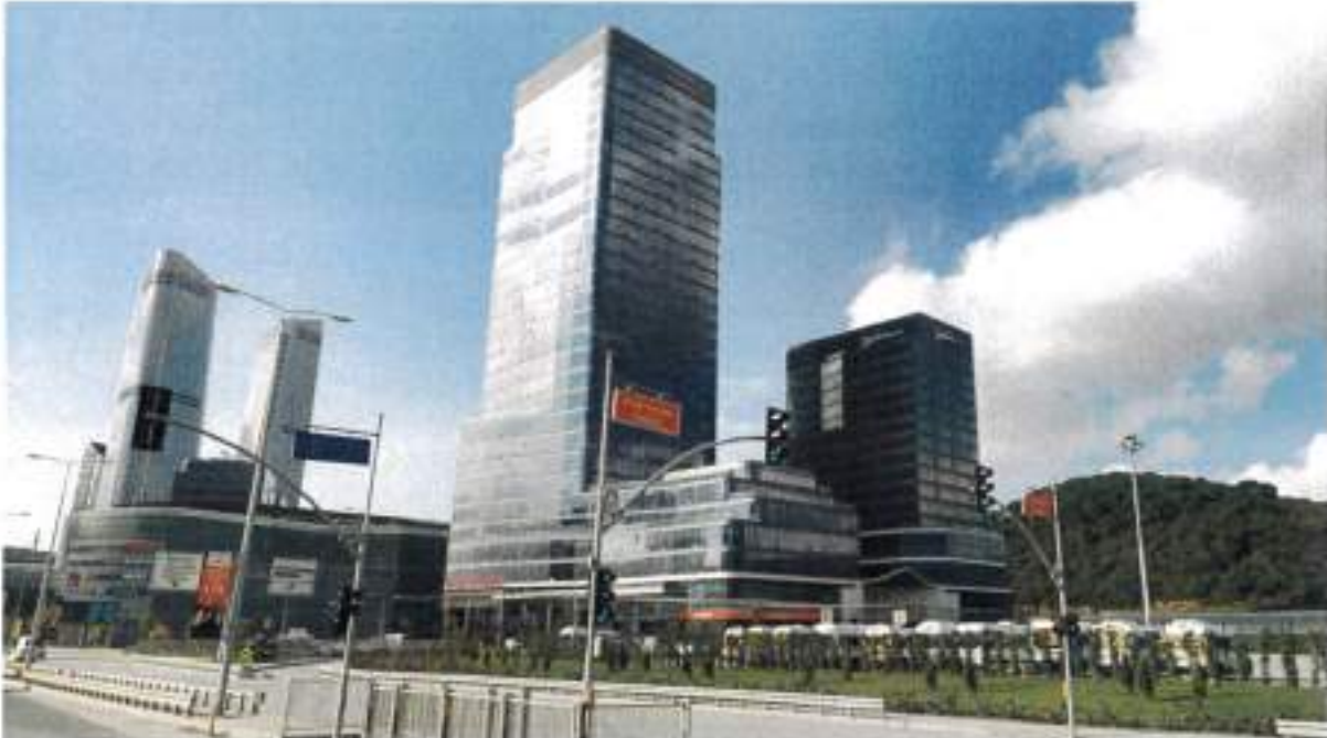
Görsel.8. 10629 ada 1 parselden görünüm (kuzeydoğu)
