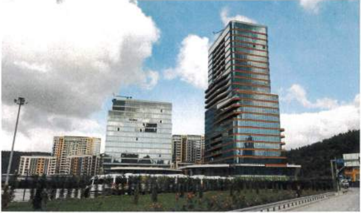
Görsel.7. 10637 ada 1 parselden görünüm (güney)
