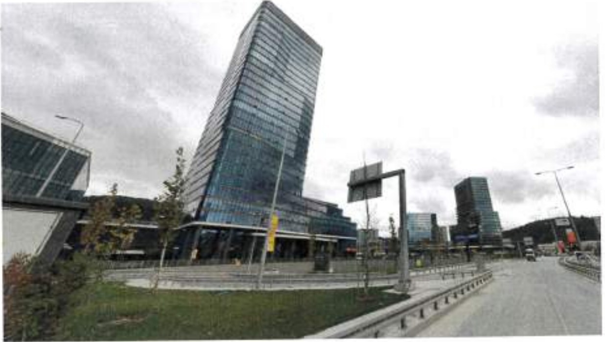
Görsel.10. 10629 ada 1 parselden görünüm (güneydoğu)
