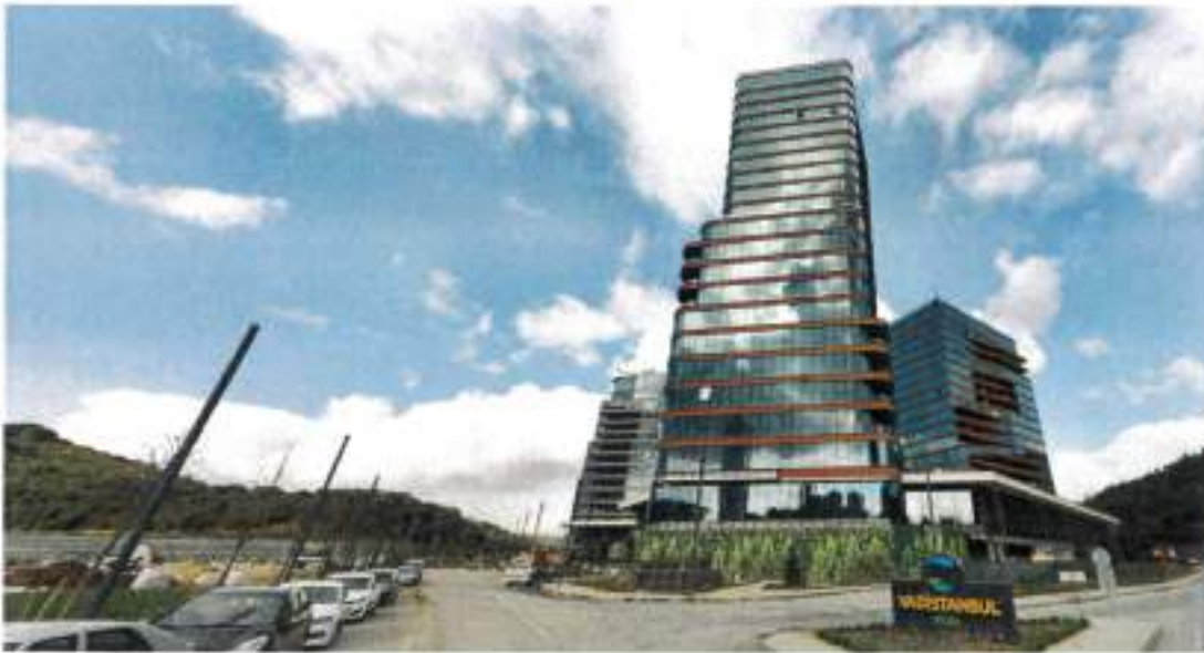
Görsel.6. 10637 ada 1 parselden görünüm (güneydoğu)
