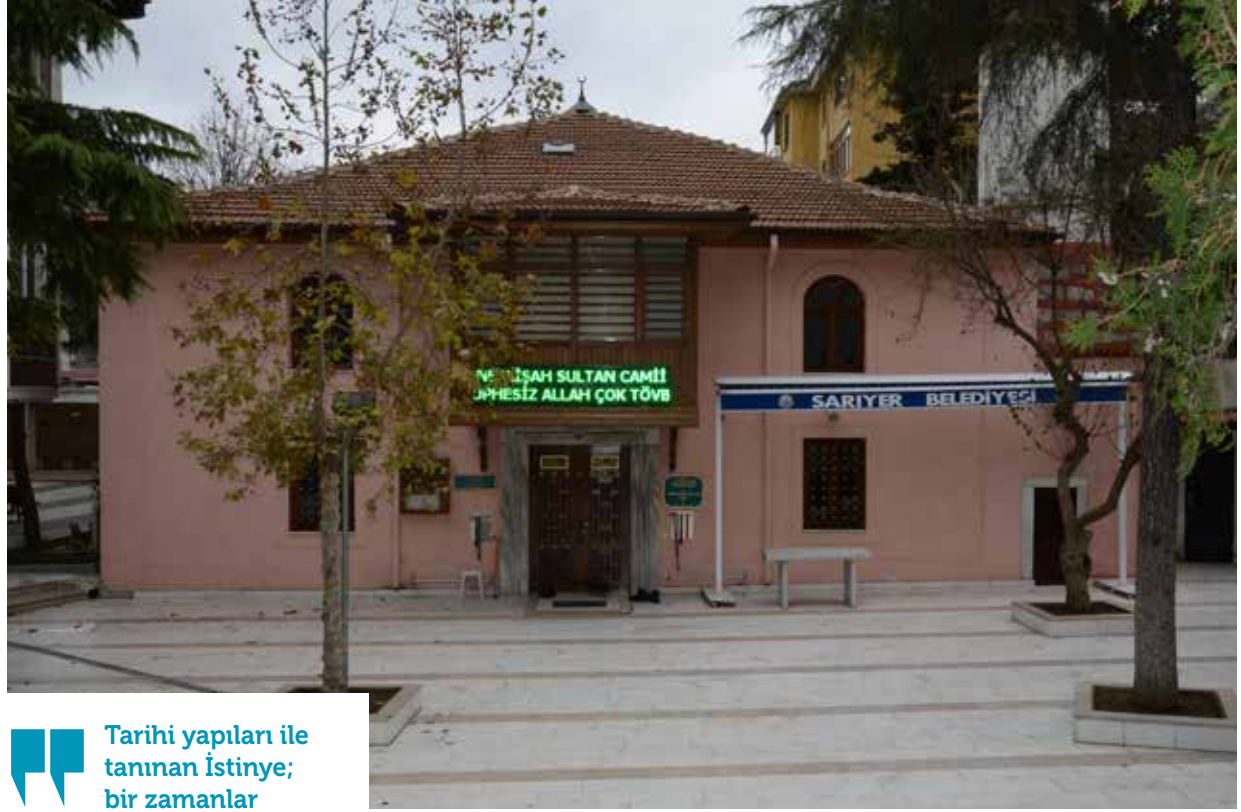
Neslişah Sultan Camii
