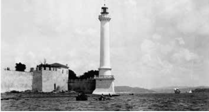
1890'lı yıllarda Ahırkapı Feneri.
