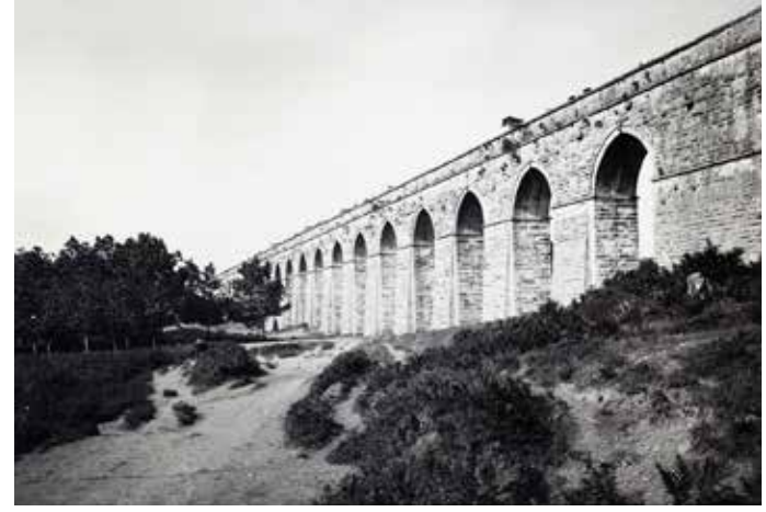
1732'de inşa edilen I. Mahmud Kemerı.
