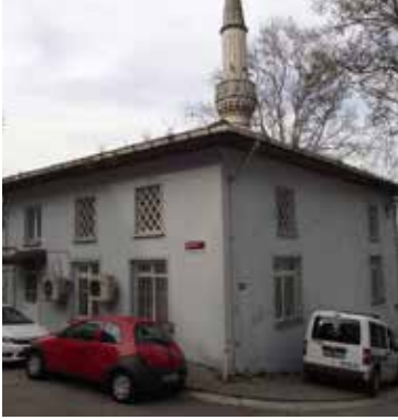
Kireçburnu Camii (Ağaçaltı Camii)
