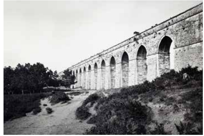
1732'de inşa edilen I. Mahmud Kemerı.
