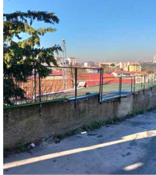
FSM Mahallesi Merkez Camii Caddesi Duvar Üzeri Çesme Korkuluk Çalışması
