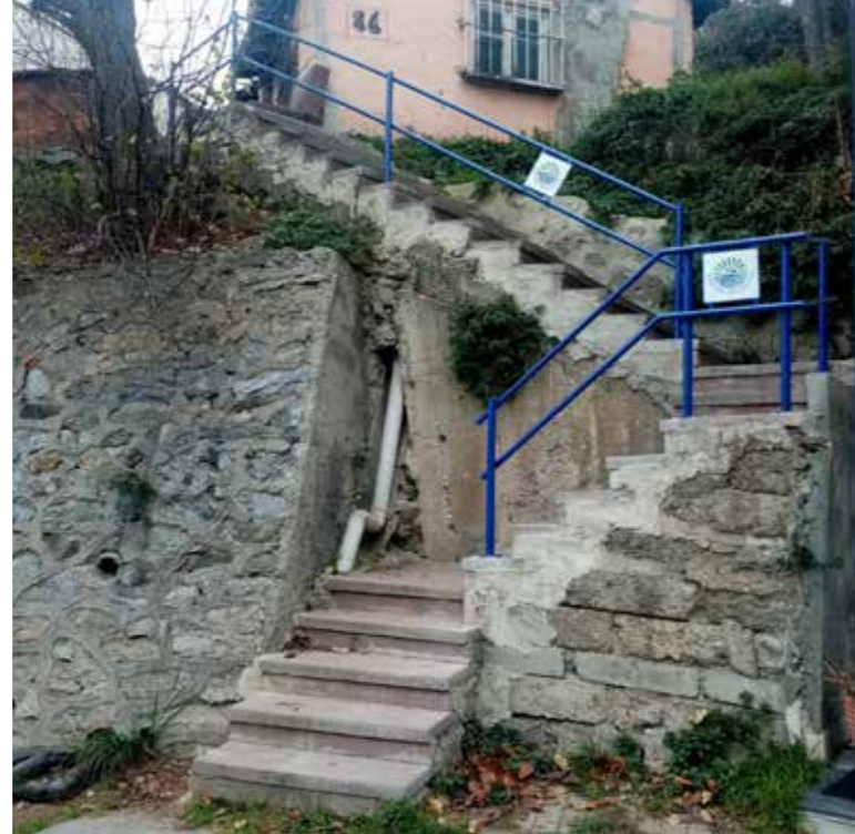
Reşitpaşa Mahallesi Postayolu Caddesi Merdiven Çalışması
