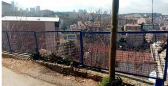
Reşitpaşa Mahallesi Kubilay Sokak Duvar Üzeri Korkuluk Çalışması
