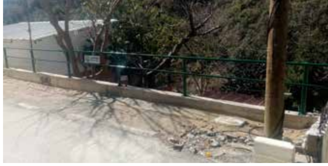
Maden Mahallesi Özdereci Sokak Duvar Üzeri Korkuluk Çalışması
