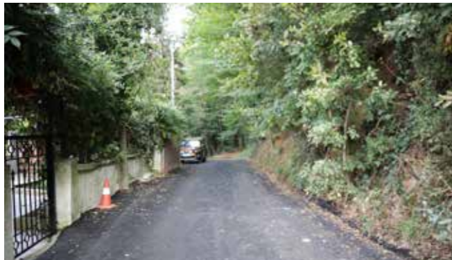
Bahçeköy Merkez, Begonvil Sokak Asfalt Çalışması
