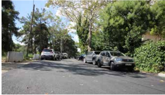
Maslak, Sipahi Ocağı Asfalt Çalışması
