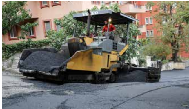
Bahçeköy Yenimahalle, Orman Sokak Asfalt Çalışması
