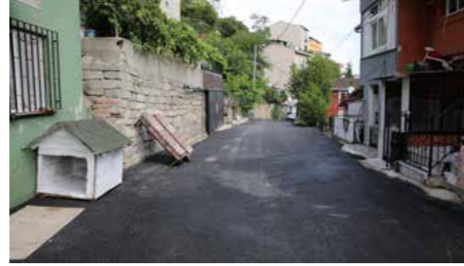
Pınar Mahallesi, Bahadır Sokak Asfalt Çalışması
