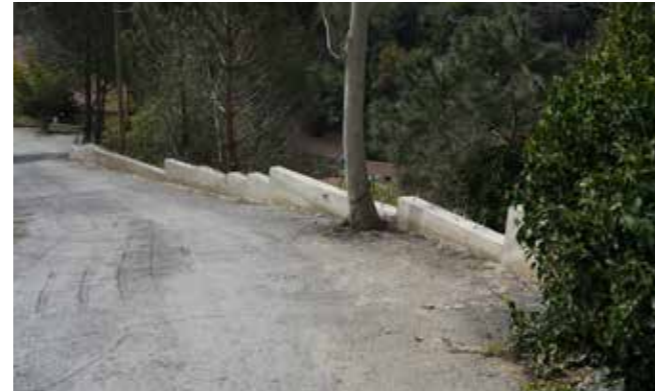
Büyükdere, Onur Çıkma Mühendis Şevket İstinat Duvarı Çalışması
