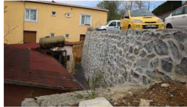
Kazım Karabekir, Emekçi Sokak Sıva Duvar Çalışması
