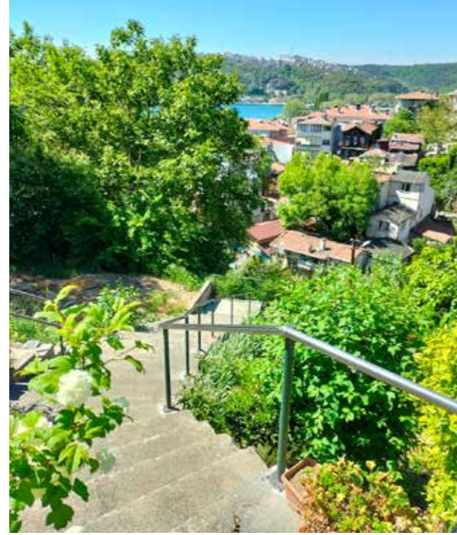
Kocataş, Canfes Sokak Merdiven Korkuluğu Çalışması
