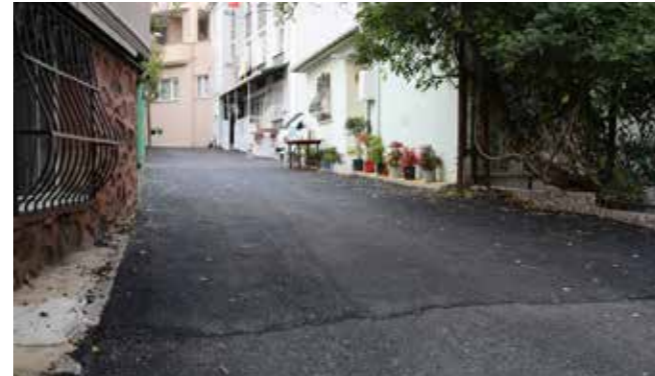
Bahçeköy Merkez, Fuşan Sokak Asfalt Çalışması
