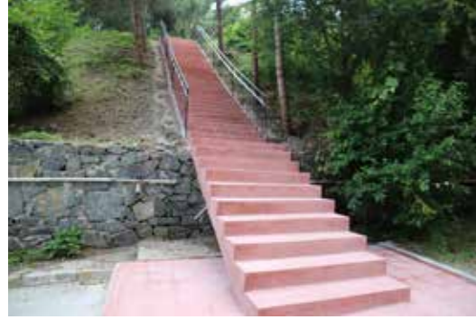
Yeni Uyum Sitesi, Merdiven Çalışması
