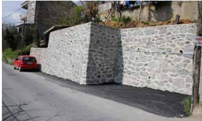
Kazım Karabekir, Cami Sokak Sıva Duvar Çalışması
