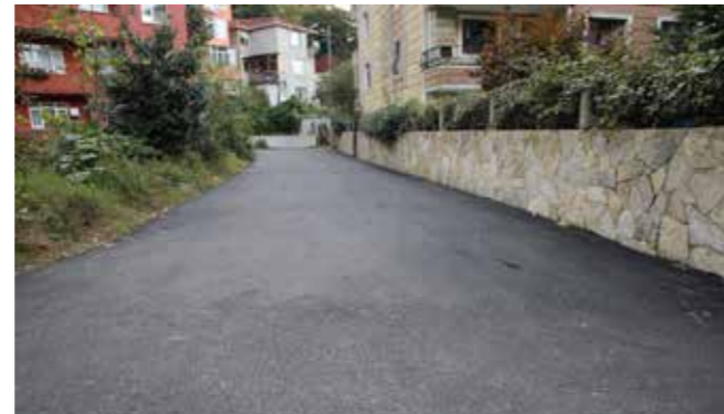
Bahçeköy Merkez, Ergene Nehri Sokak Asfalt Çalışması
