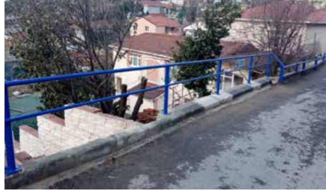
Kocataş, Günaydın Sokak Yol Kenarı Korkuluk Çalışması
