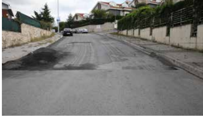
Zekeriyaköy, Fırat Caddesi Asfalt Çalışması
