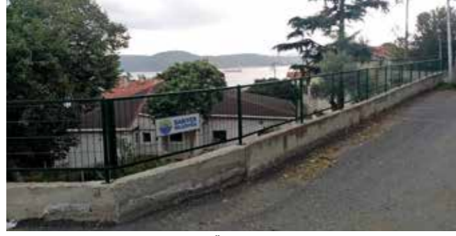
Büyükdere, Yiğit Çıkmaz Sokak Duvar Üzeri Korkuluk Çalışması
