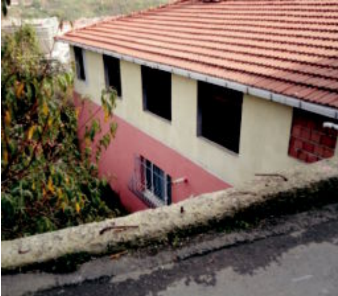
İzin verilen çatı ve mantolama faaliyetleri
