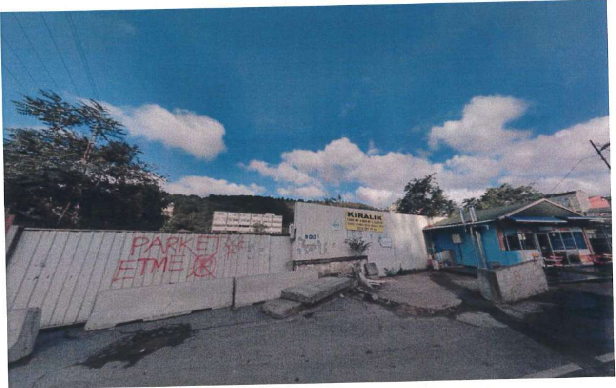
Fotoğraf 2: Parselin Doğu Cephesi Görünümü
